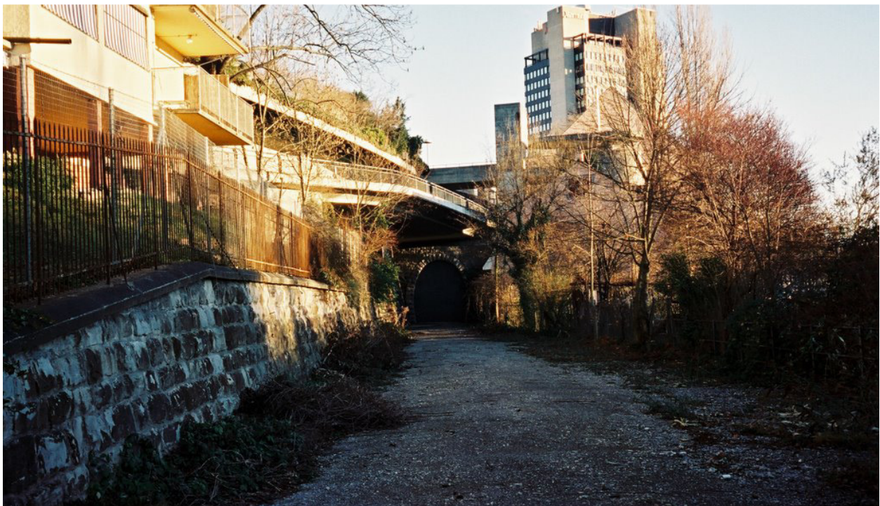
Zuschüttung des Stadtzürcher Letten-Tunnels, 2002-2004
